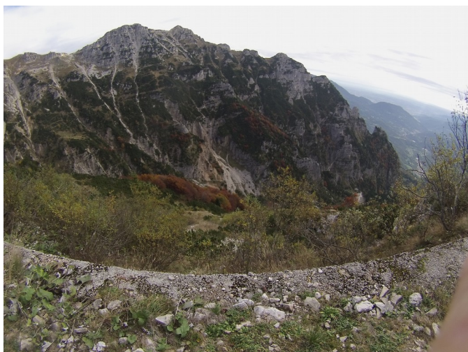
Strada delle 52 Gallerie
